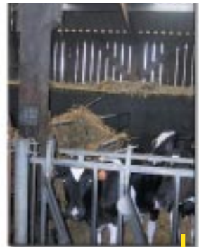
Le bardage ajouré : un bon moyen de ventilation.
